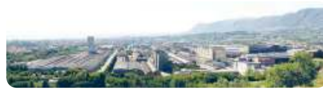
Una panoramica dello stabilimento di Terni. Gli impianti di AST coprono un'area di oltre 1.500.000 mq
